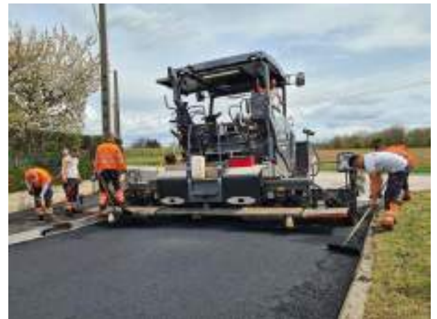
Réfection du revêtement bitumeux de la Route de Glay
