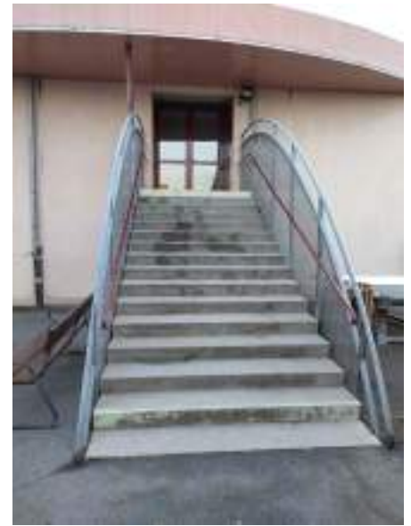
Main courante sur l'escalier extérieur de l'école
